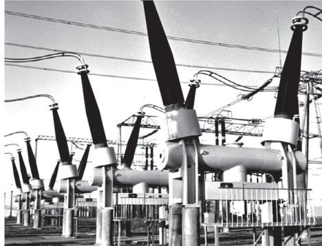
b) Disjuntor de Tanque Morto
