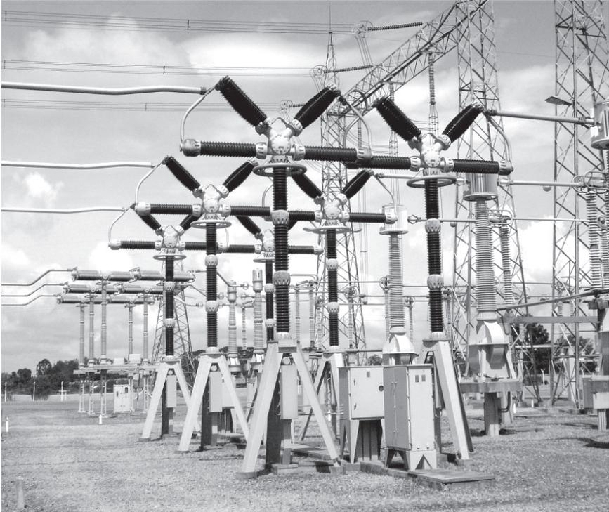
**Figura 14.5** Subestação com destaque para disjuntores Merlin Gerin FA4 (550kV)
