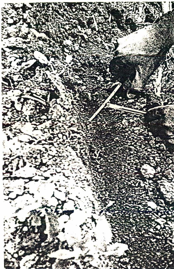
Figura 7.5 - Verificação da regularidade de profundidade.
